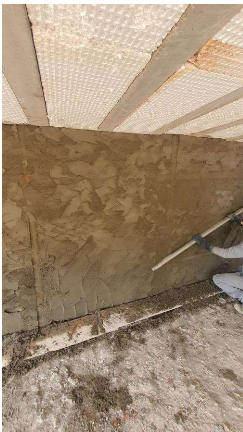
FIGURA 10/11 - EXECUÇÃO REBOCO EXTERNO
