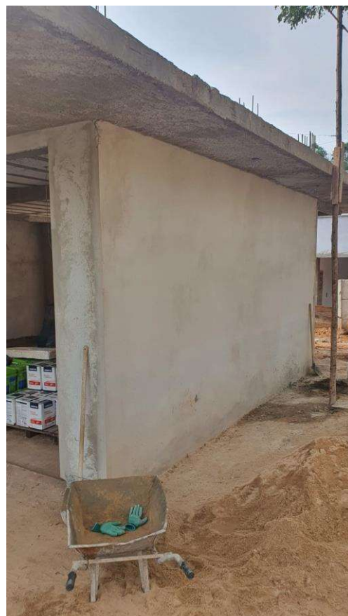
FIGURA 10/11 - EXECUÇÃO REBOCO EXTERNO
