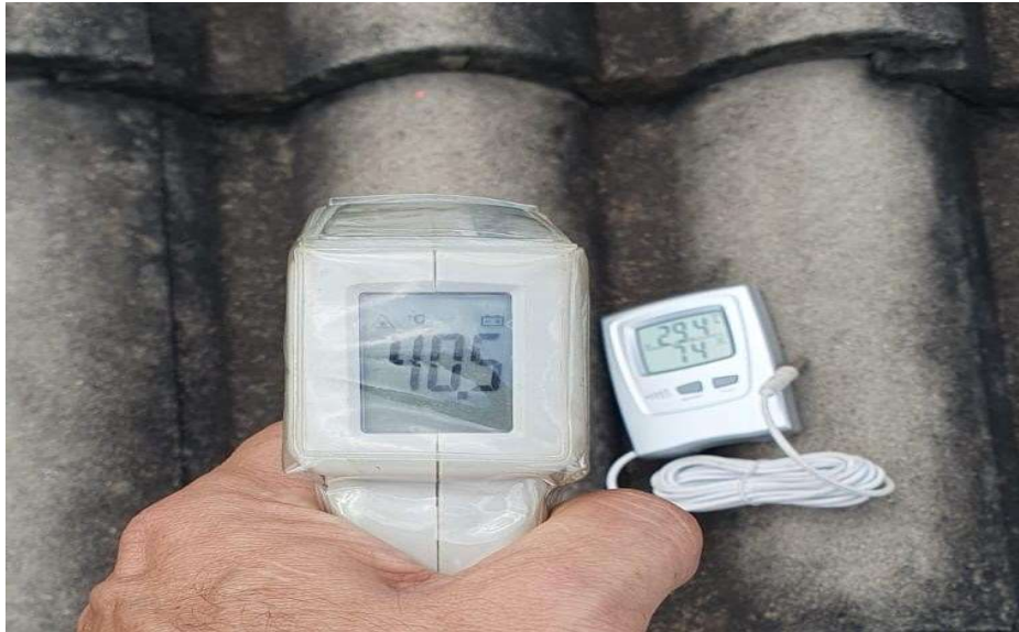
Figura 9 –Medições de temperatura do sistema de cobertura com telha de concreto
