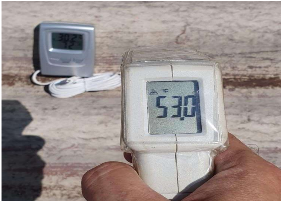
Figura 11 – Medição de temperaturas da cobertura com telhas de fibrocimento.
