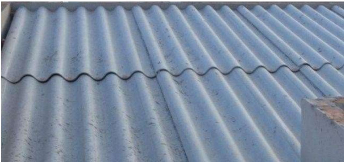
Figura 6 - Telha de fibrocimento
